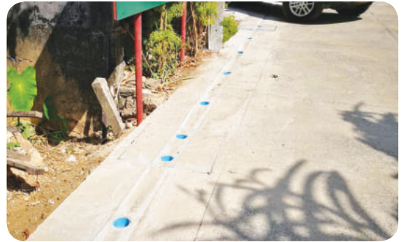
โครงการก่อสร้างคูระบายน้ำ ค.ส.ล. และงาน Gutter ซอยพรุใหญ่ 1 หมู่ที่ 6
