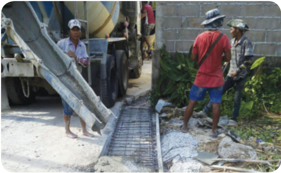
โครงการก่อสร้างคูระบายน้ำ ค.ส.ล. และงาน Gutter ซอยพรุใหญ่ 1 หมู่ที่ 6
