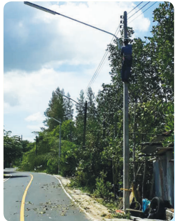
ขยายเขตไฟฟ้าสาธารณะ ซอยพัชณี - หัวท่า หมู่ที่ 3 ●
