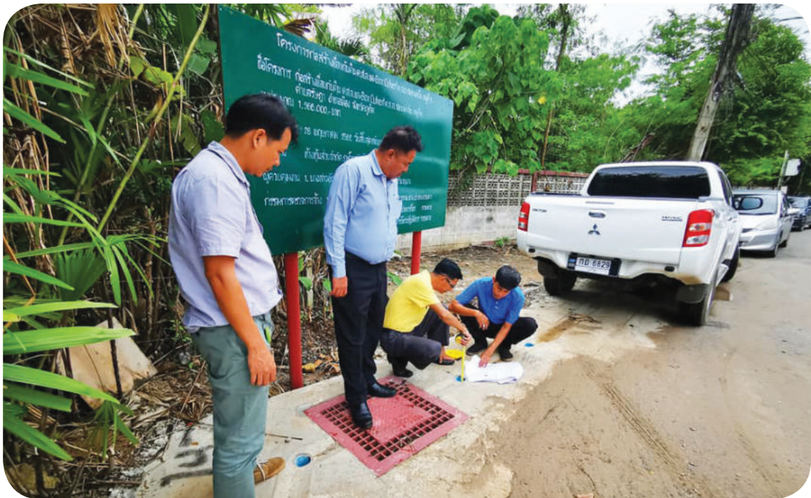
โครงการก่อสร้างเขื่อนกันดิน ค.ส.ล. และ Box Culvert ซอยแม่กลิ้ง หมู่ที่ 3
